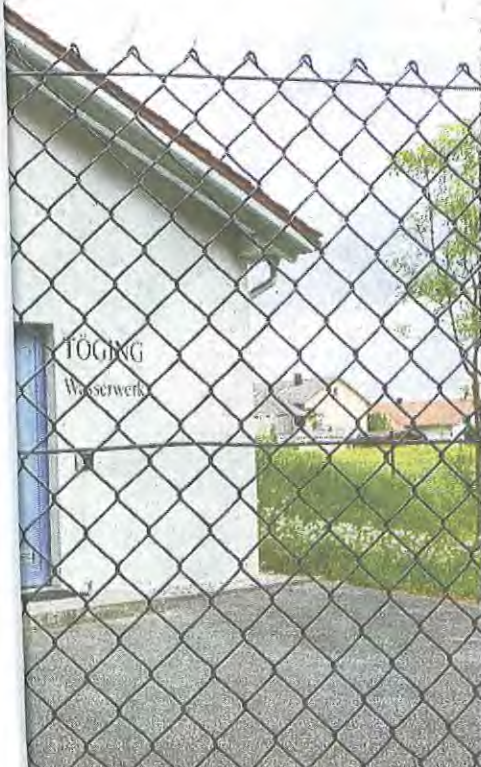
Entwicklungen in Sachen Töginger Trinkwasserleitung nicht aus. FOTO HA
